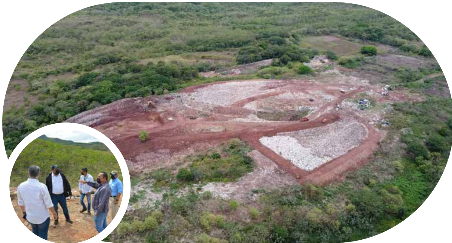
Vertedero en Santiago de Veraguas
